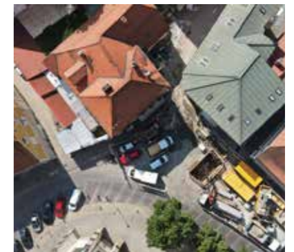
Slika prikazuje primer izgradnje kanalizacije v centru mesta, brez velikih posegov (gradnja na globini 4 metrov)
