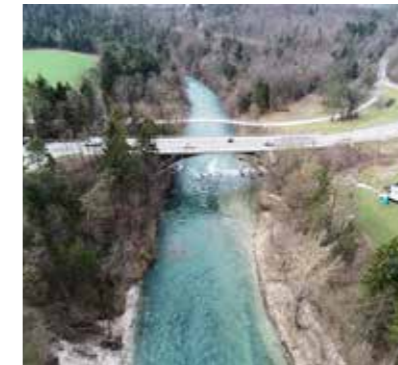
Slika prikazuje izgradnjo visokonapetostnega kablovida pod reko Savo, brez posega v samo reko, obrečni del ter okolje.
